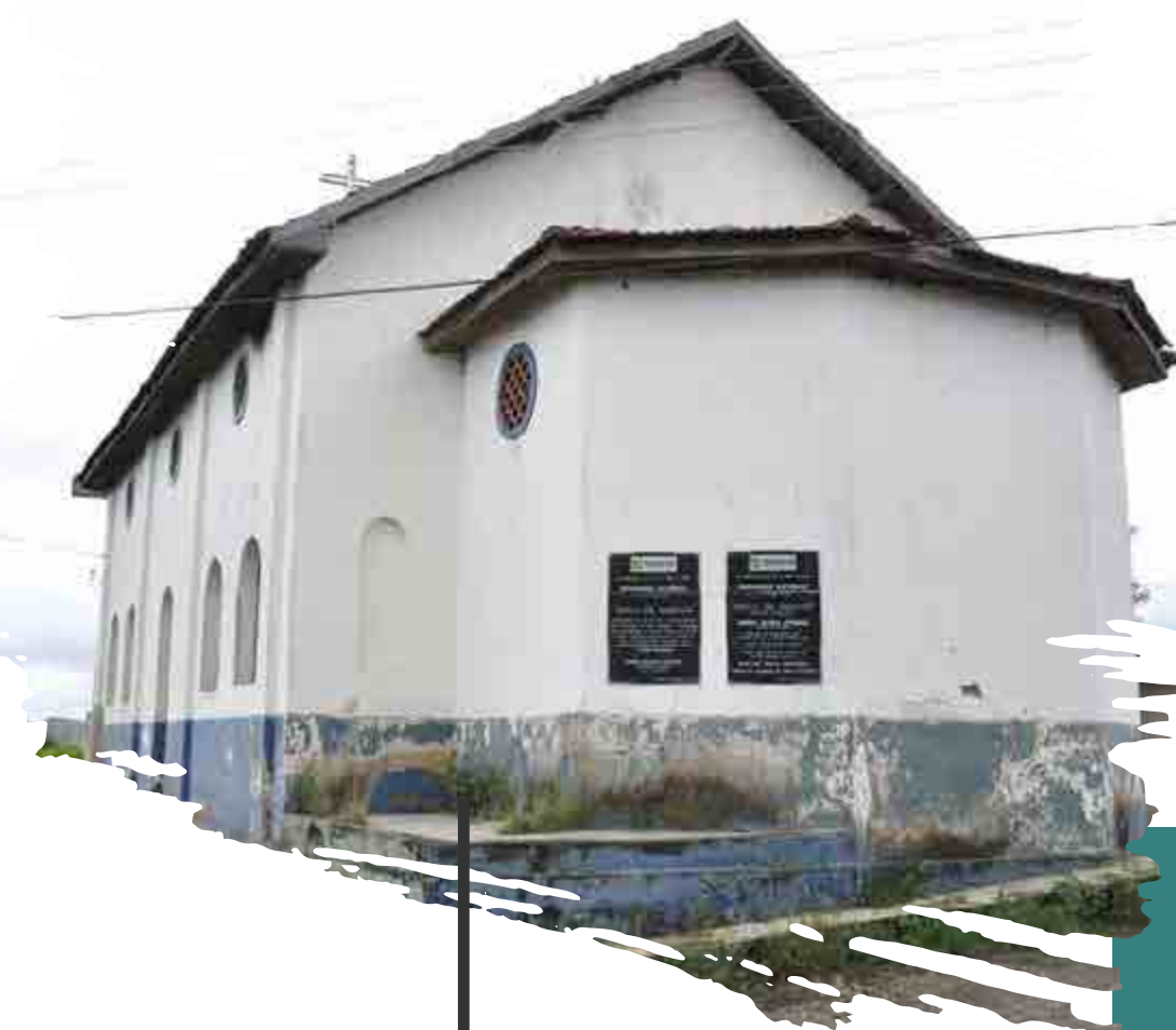
Capela de São Sebastião
